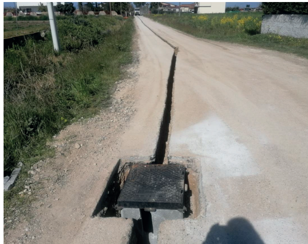
Posa del pozzetto di ispezione
