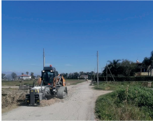
Fresatura e scavo in minitrincea
