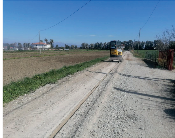
Pulizia dello scavo
