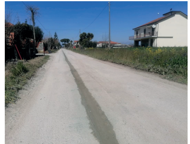
Rinterro dello scavo
